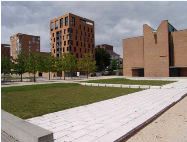
Figure 14 - Bassin sec devant l'école du quartier de Scharnhausepark, Stuttgart. Les eaux de pluie de la toiture s'écoulent librement dans une partie revêtue à l'entrée de ce bassin sec. Photo Valérie Mahaut.
