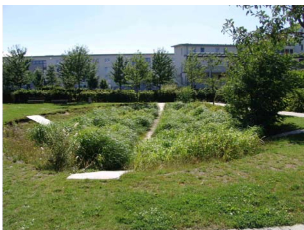
Figure 9 - Bassin sec planté. Quartier du Kronsberg, Hanovre. Photo Valérie Mahaut.
