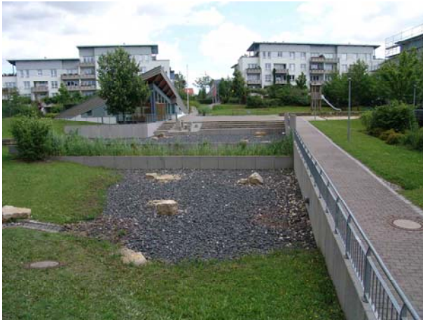
Figure 10 - Bassin sec minéralisé, en gravier. Quartier du Kronsberg, Hanovre. Photo Valérie Mahaut.
