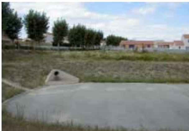
Figure 7 - Bassin sec à Pollestres, France (66). Fond revêtu, berges engazonnées, hauteur d'eau importante. Source : DDE 66 [9].
