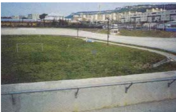
Figure 6 - Bassin sec de Vitrolles en vélodrome (France). Fond engazonné (terrain de football), berges revêtues (vélodrome), de hauteur d'eau importante. Source : [1].
