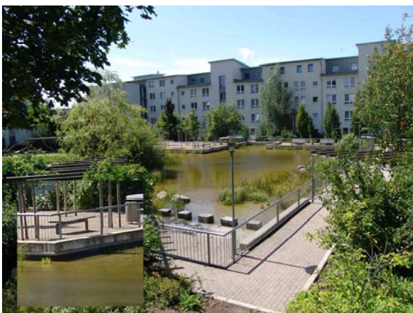
Figure 5 - Bassin en eau de rétention. Ce grand étang de forme plus géométrique permet un marnage de quelques dizaines de centimètres de haut. On le remarque à la géo-membrane qui dépasse de manière peu élégante de la surface de l'eau. Quartier du Kronsberg, Hanovre. Photo Valérie Mahaut.
