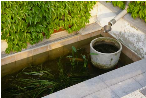
Figure 4 - Bassin en eau au pied de la façade arrière d'une maison mitoyenne bruxelloise. Un marnage d'une bonne vingtaine de centimètres est prévu en cas d'orage permettant le stockage temporaire d'un volume d'eau avec restitution en différé vers l'égout : un simple tuyau vertical sert à la fois de surverse en cas d'orage trop important mais aussi d'évacuation à débit régulé via les petits trous pratiqués au niveau des basses eaux. Photos Bernard Deprez.
