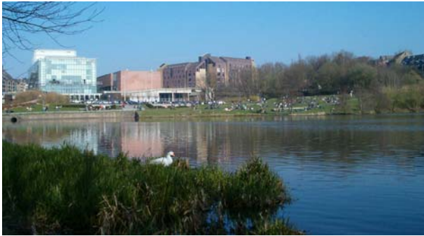
Figure 6 - Lac de rétention de Louvain-la-Neuve qui reçoit les eaux de pluie du réseau séparatif de la ville neuve. L'évacuation des eaux stockées sont déversées à débit régulé dans un ruisseau affluent de la Dyle. Photo Valérie Mahaut.
