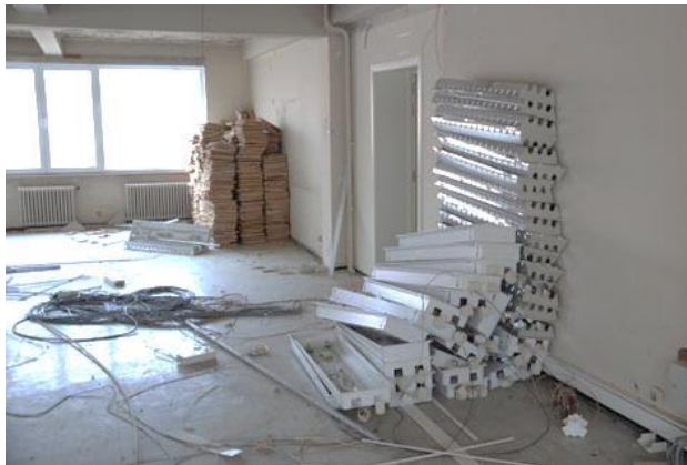
Demontage, sortering ter plaatse
