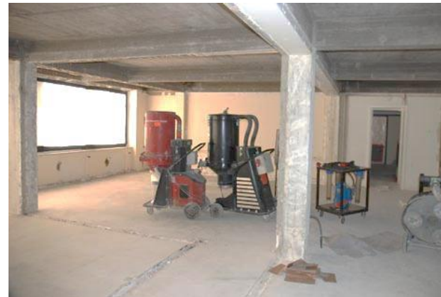
Asbestverwijdering
