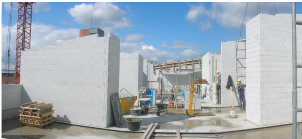
ruwbouw uit superisolerende cellenbeton-blokken.
