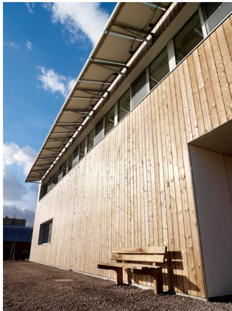
gevelbekleding van duurzaam veredeld hout
