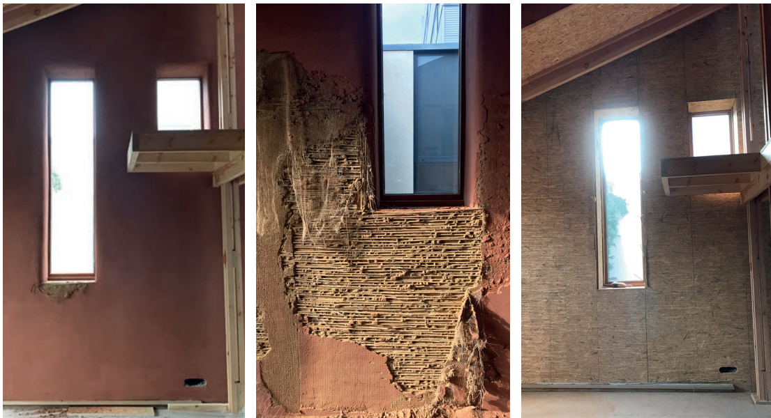
Afbeelding 88: Afwerking in klei op een geschroefde rietmat (Bron: Caroline Morizur, efp)
