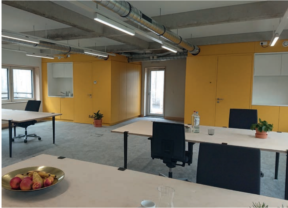
Afbeelding 29: Doordachte positionering van de horizontale technieken en de technische en sanitaire cellen in het Circular Retrofit Lab.
