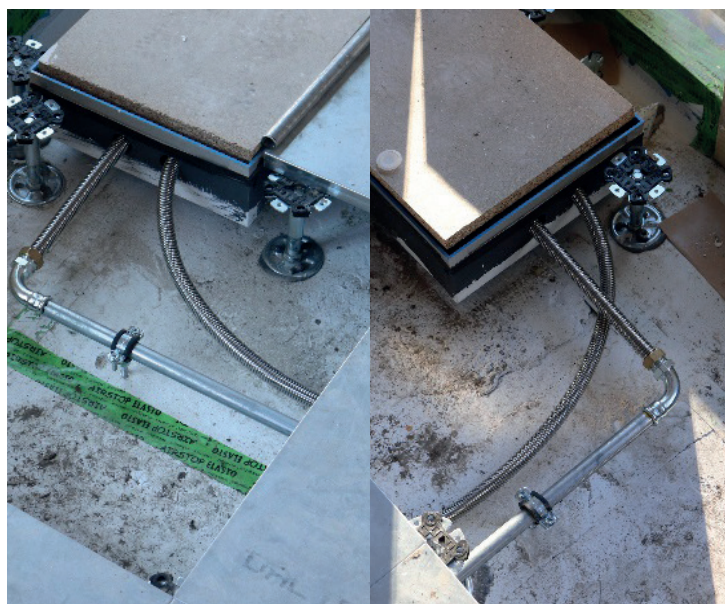
Afbeelding 104: Volledige onafhankelijkheid: demonteerbare verhoogde vloer (Bron: Architectural Engineering, VUB)
