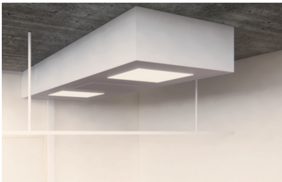
Afbeelding 156: Gestandaardiseerde technisch eiland bevat alle technische uitrustingen zoals verlichting en ventilatie (Bron: archipelago architects)
