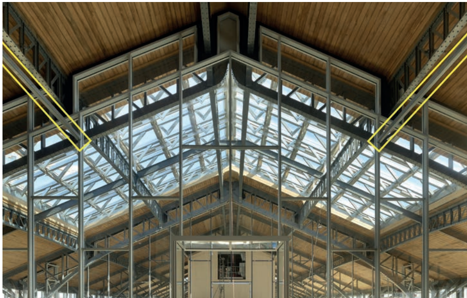
Afbeelding 126: Binnenzijde van dezelfde gevel met langs binnen de stalen koker die ter afsteuning naar het CLT-volume loopt. (Bron: Toon Grobet)
