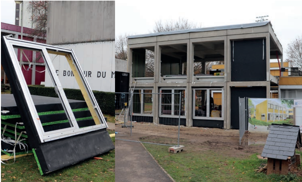
Afbeelding 105: Niet-dragende gevelelementen (Bron: Architectural Engineering, VUB)
