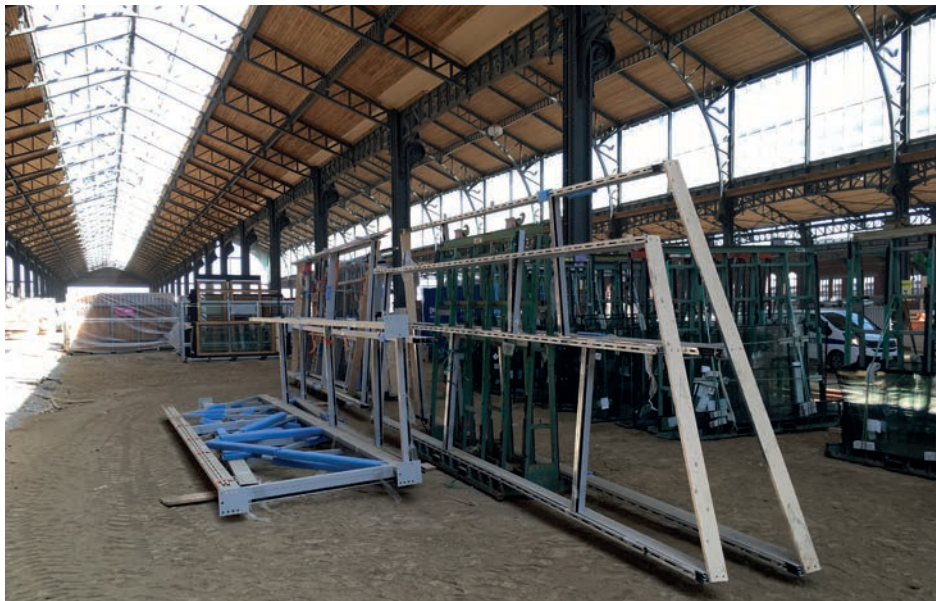
Afbeelding 129: Geprefabriceerde elementen tijdelijk opgeslagen op de werf. (Bron: Jansen AG)
