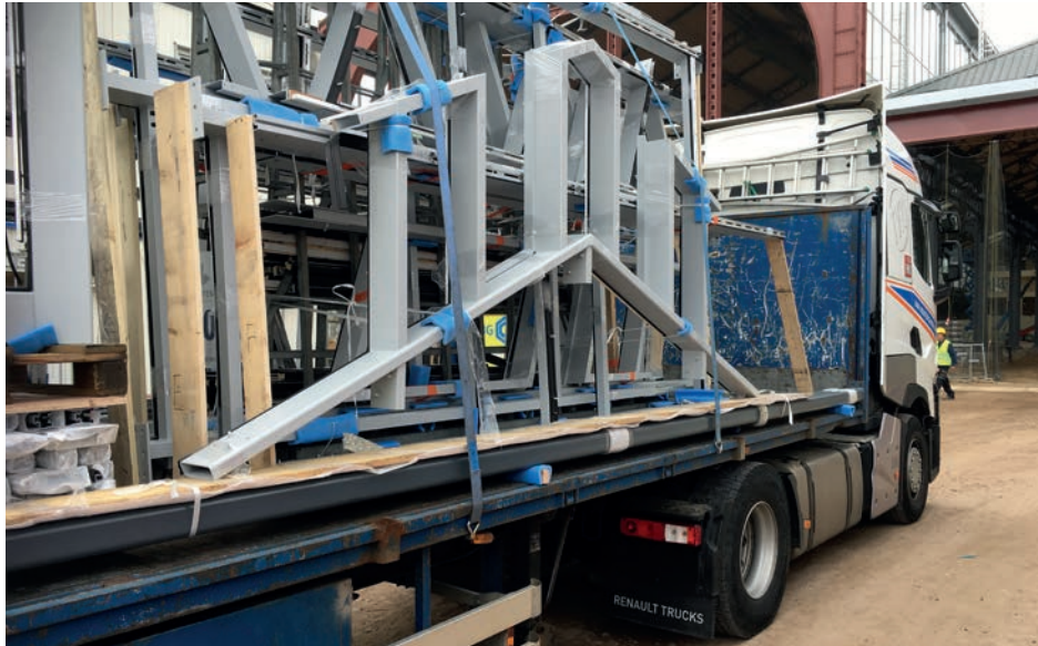
Afbeelding 128: Aankomst geveldelen en -stijlen op de werf. (Bron: Jansen AG)
