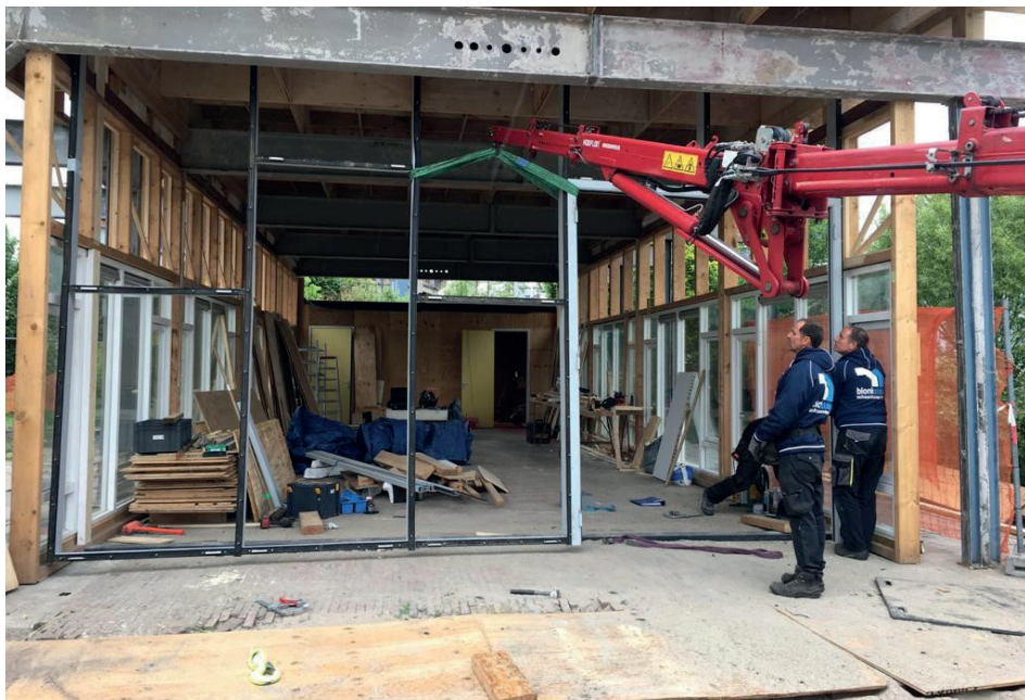
Afbeelding 120: Plaatsing draagstructuur tweede fase. (Bron: Blonkstaal)
