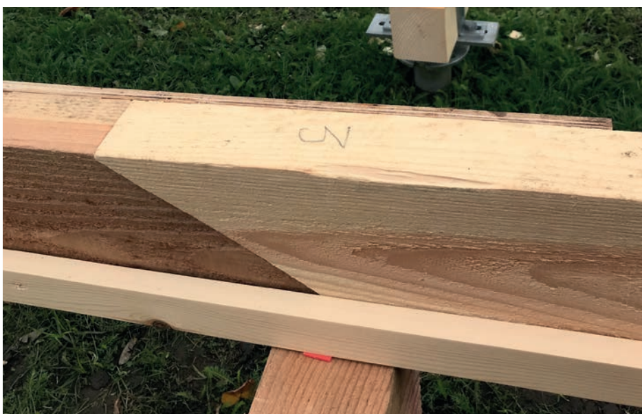
Afbeelding 94: Verbinding in verstek. (Bron: Caroline Morizur, efp)
