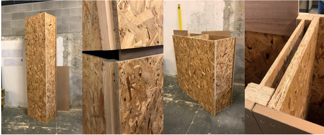
Afbeelding 93: Assemblage van de gevelelementen (Bron: Caroline Morizur, efp)
