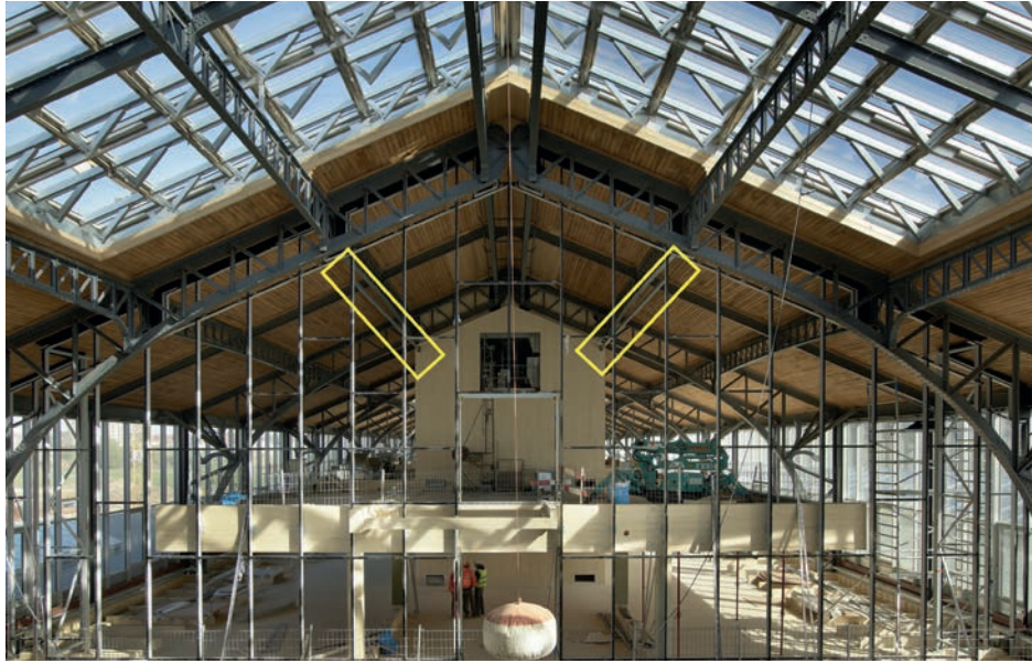
Afbeelding 125: Buitenzijde van dezelfde gevel met aan de achterzijde de stalen koker die ter afsteuning naar het CLT-volume loopt. (Bron: Toon Grobet)
