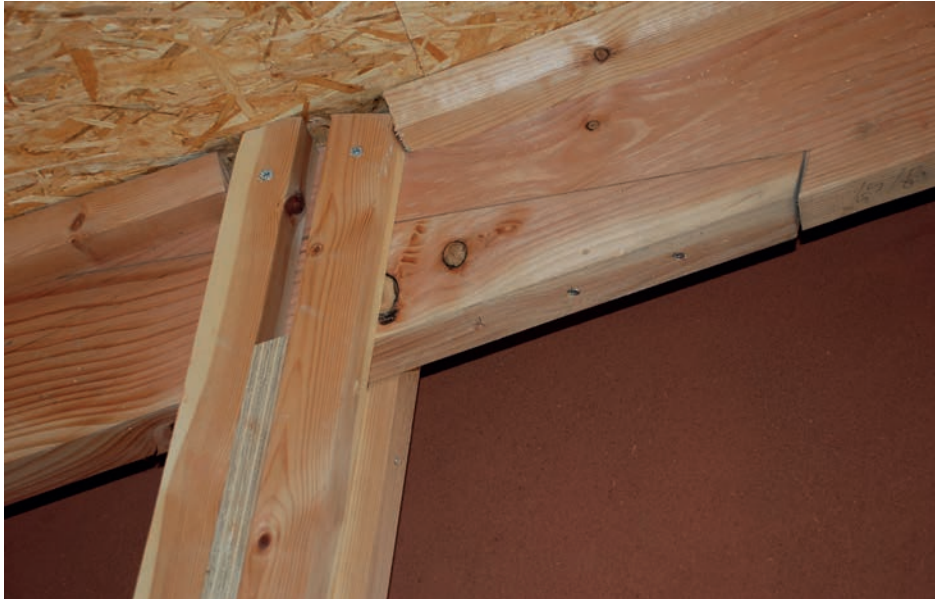
Afbeelding 87: De draagstructuur en de schil zijn onafhankelijk (Bron: Caroline Morizur, efp)
