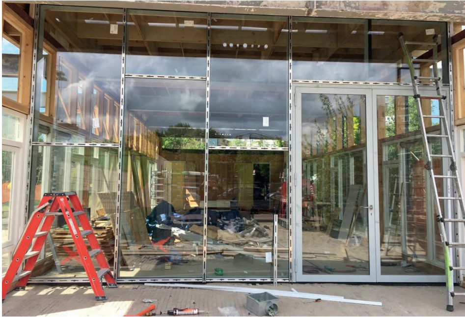
Afbeelding 121: Plaatsing draagstructuur tweede fase. (Bron: Blonkstaal)
