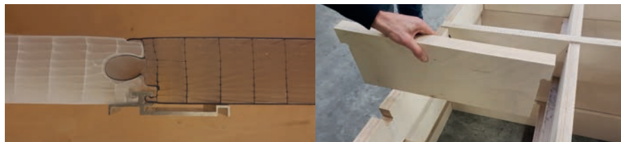
Afbeelding 68: Voorbeelden van vergrendelverbindingen. (Bron: E. Durmisevic)
