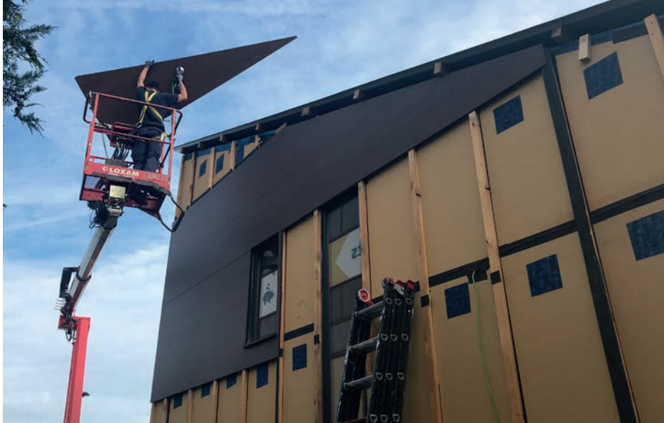
Afbeelding 89: Démontage van de gevelpanelen (Bron: Caroline Morizur, efp)
