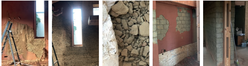
Afbeelding 71: Afbraak van leempleister in het BRIC-project. (Bron: EFP – Caroline Morizure)
