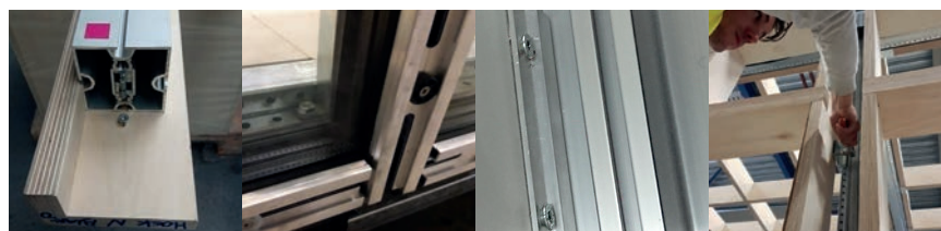
Afbeelding 70: Voorbeelden van indirecte droge verbindingen. (Bron: E. Durmisevic)
