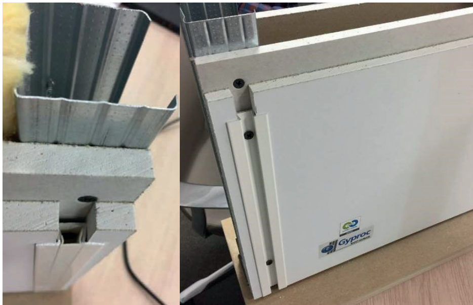
Afbeelding 109: Detail van de een profielsysteem (Bron: Architectural Engineering, VUB; Saint-Gobain)
