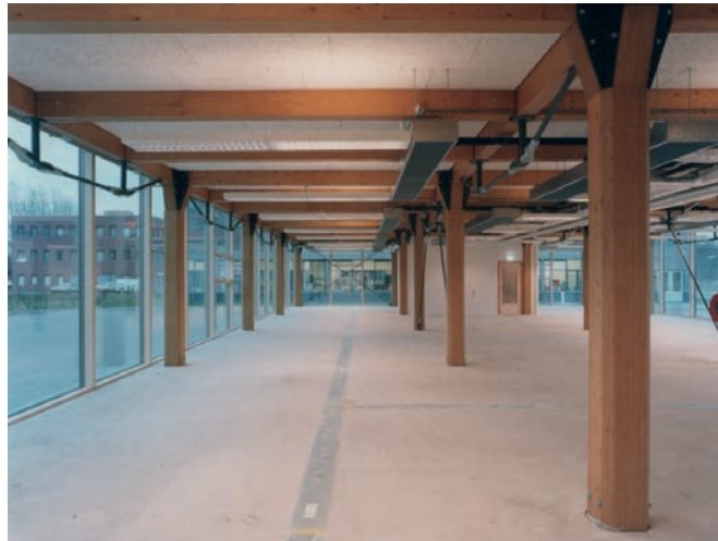
Afbeelding 44: Voor Project XX in Delft werd een omkeerbare vloer ontworpen. (Bron: Project XX, architecte Jouke Post XXarchitecten)
