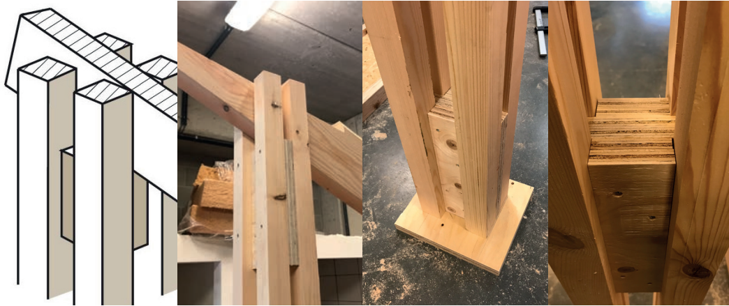
Afbeelding 91: Details van een kolom en de verbinding tussen de kolom en een balk (Bron: Caroline Morizur, efp)
