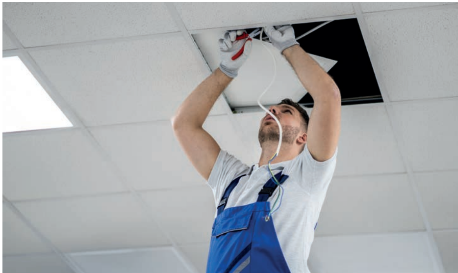
Afbeelding 8: Deze plafondplaat kan afzonderlijk gedemonteerd worden, zonder dat de aangrenzende componenten moeten worden verwijderd of beschadigd.
